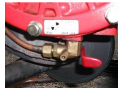
ポンプ排水バルブ
